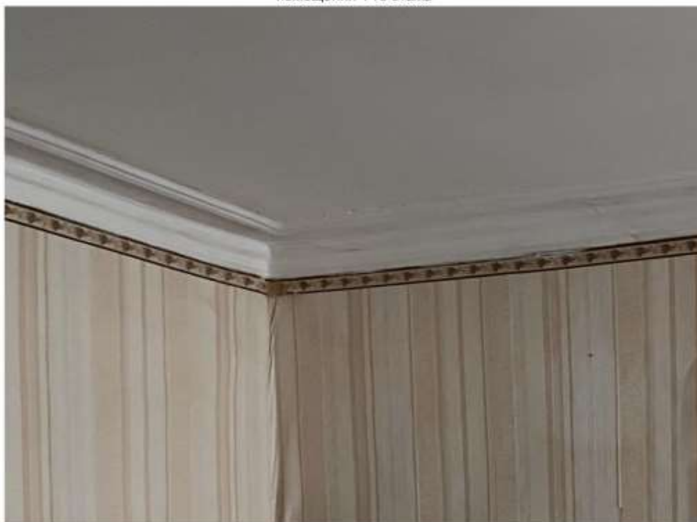
Профилированный потолочный карниз помещения 1-го этажа
