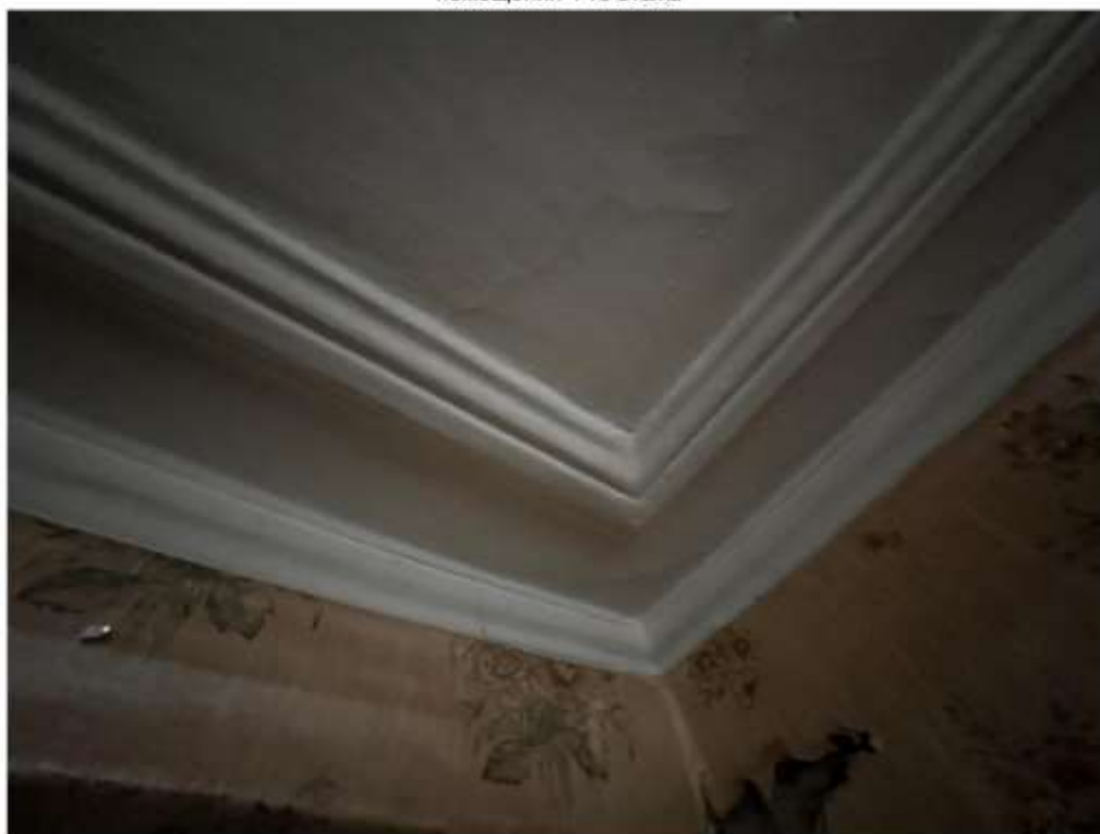
Профилированный потолочный карниз помещения 1-го этажа
