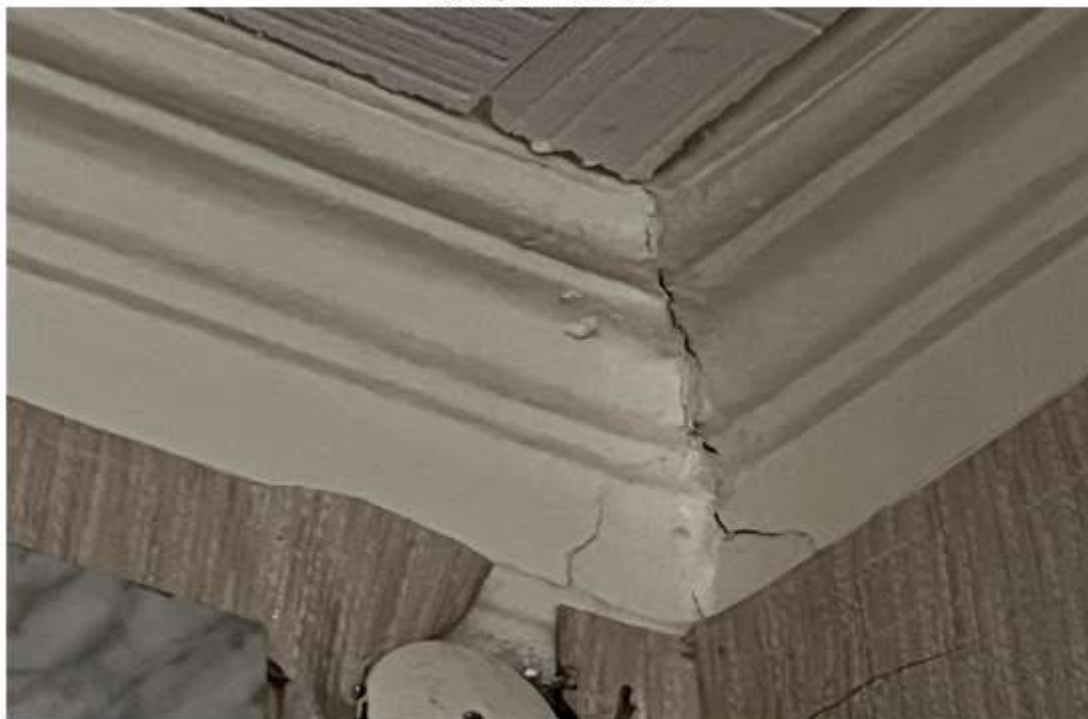
Профилированный потолочный карниз помещения 2-го этажа
